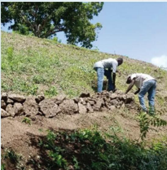
*Creación de un muro de piedras y sacos de tierra para evitar la erosión*
