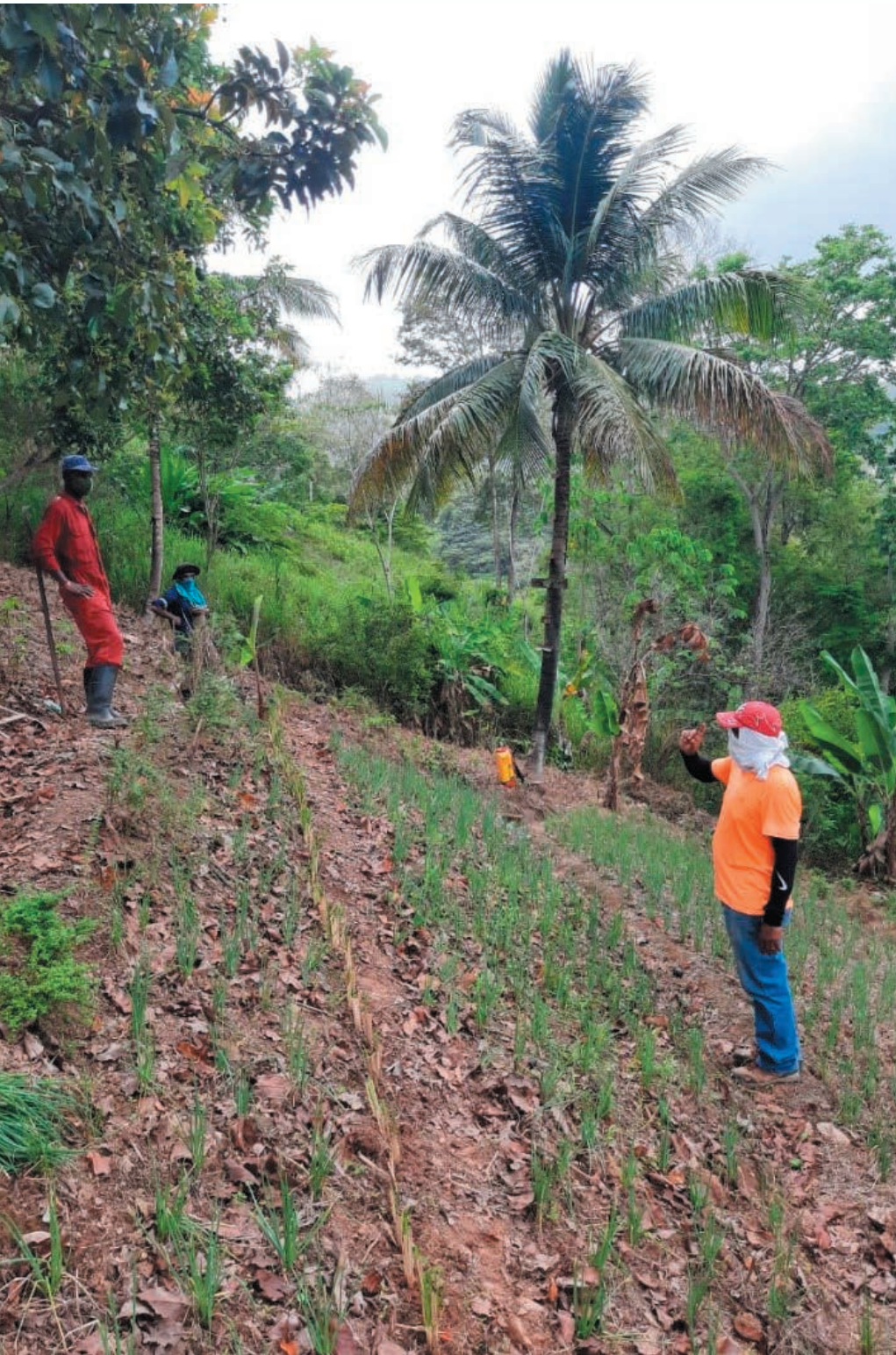
Instalación de pasto vetiver para estabilizar esta ladera y proteger contra la erosión del suelo y mejorar la calidad del suelo.
