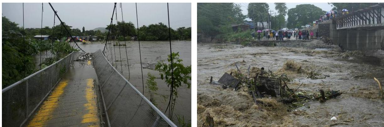
Figura 3 Puente peatonal colapsado por inundación en San Pedro Sula
